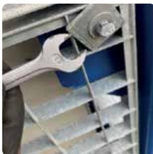
Verwenden Sie einen 13er-Ring/Steckschlüssel, um die Schrauben zu lösen.
