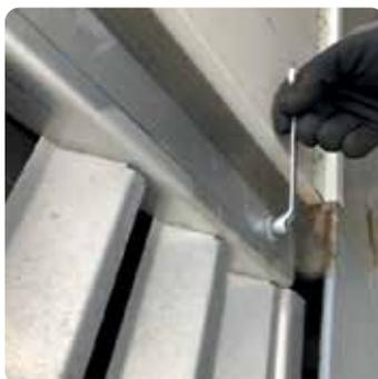
Verwenden Sie einen 10er-Ring/Steckschlüssel, um die Schrauben zu lösen.
